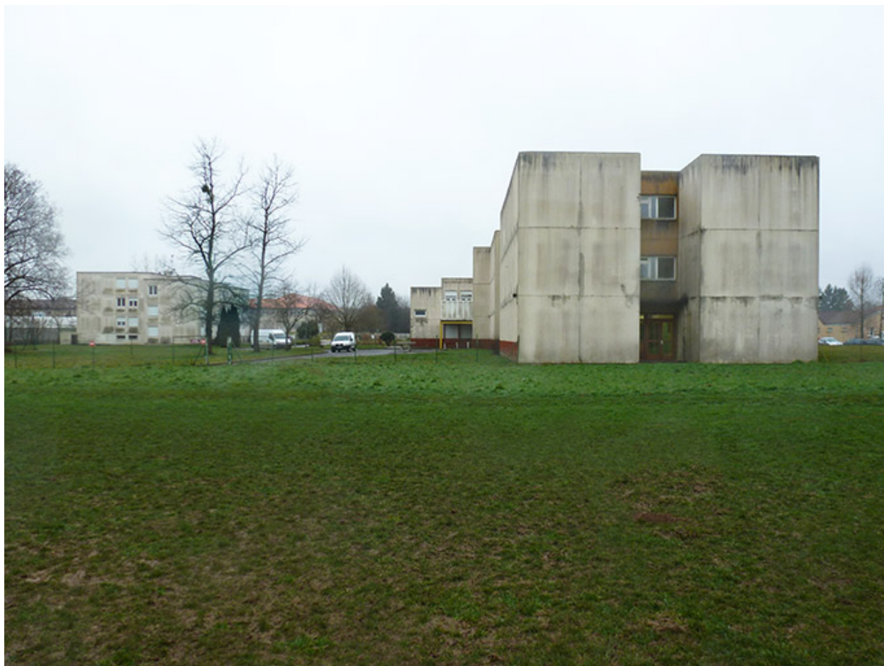
Façade nord de l'internat.
