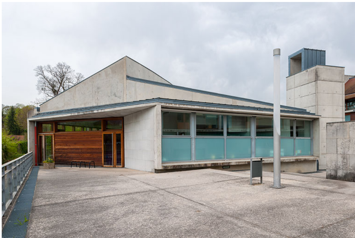
Façade sud-ouest du restaurant d'application.
