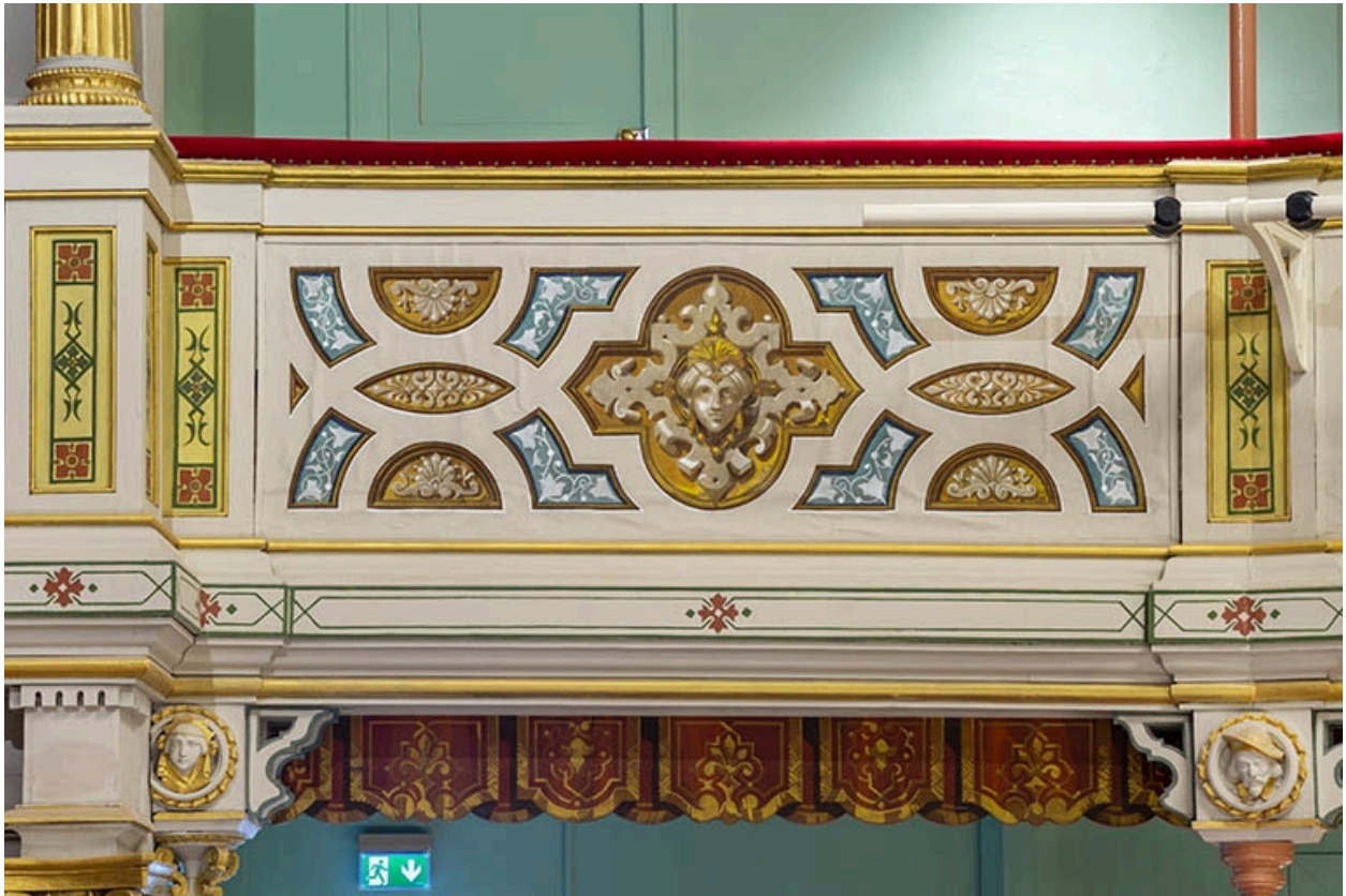
Salle : décor du garde-corps du 2e balcon, près de la loge d'avant-scène côté cour.
