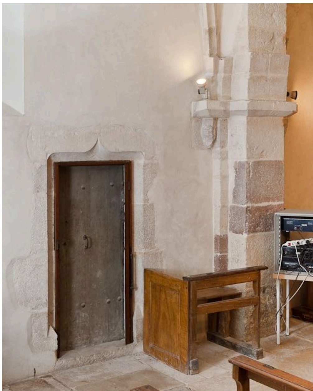
Porte de la tourelle d'escalier.
