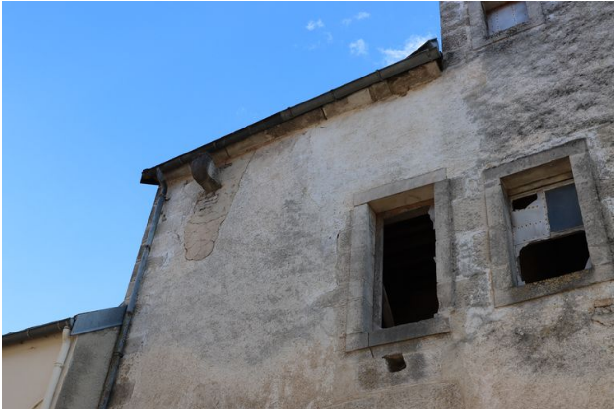
Détail des ouvertures et d'un ancien corbeau de gouttière à l'étage de l'élévation nord de la demeure.
