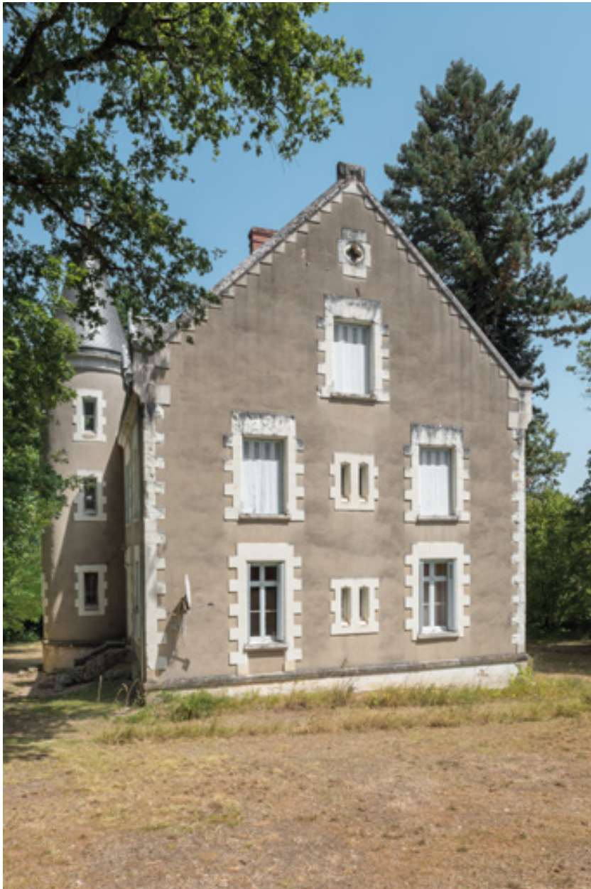
Mur pignon sud-ouest.
