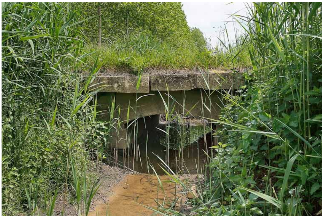
Ponceau, vue rapprochée.
