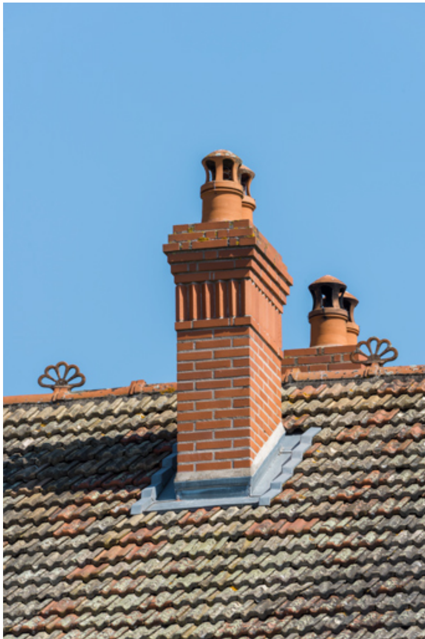
Hôtel-restaurant : souches de cheminée.
