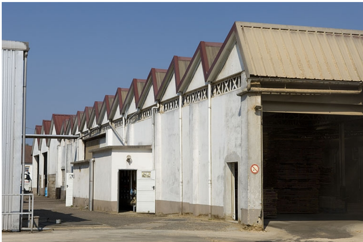
Extension sud couverte de sheds.
