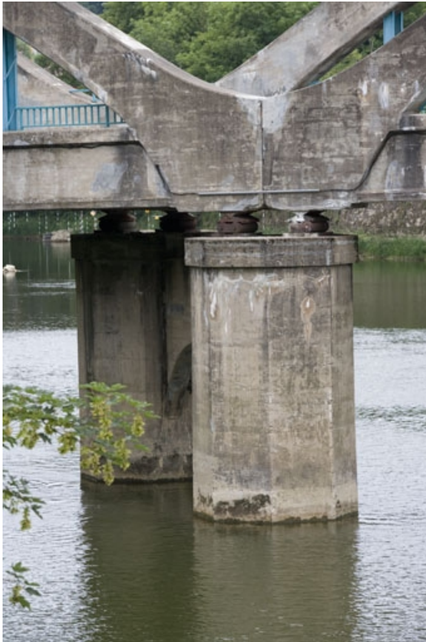
Piles côté rive gauche.
