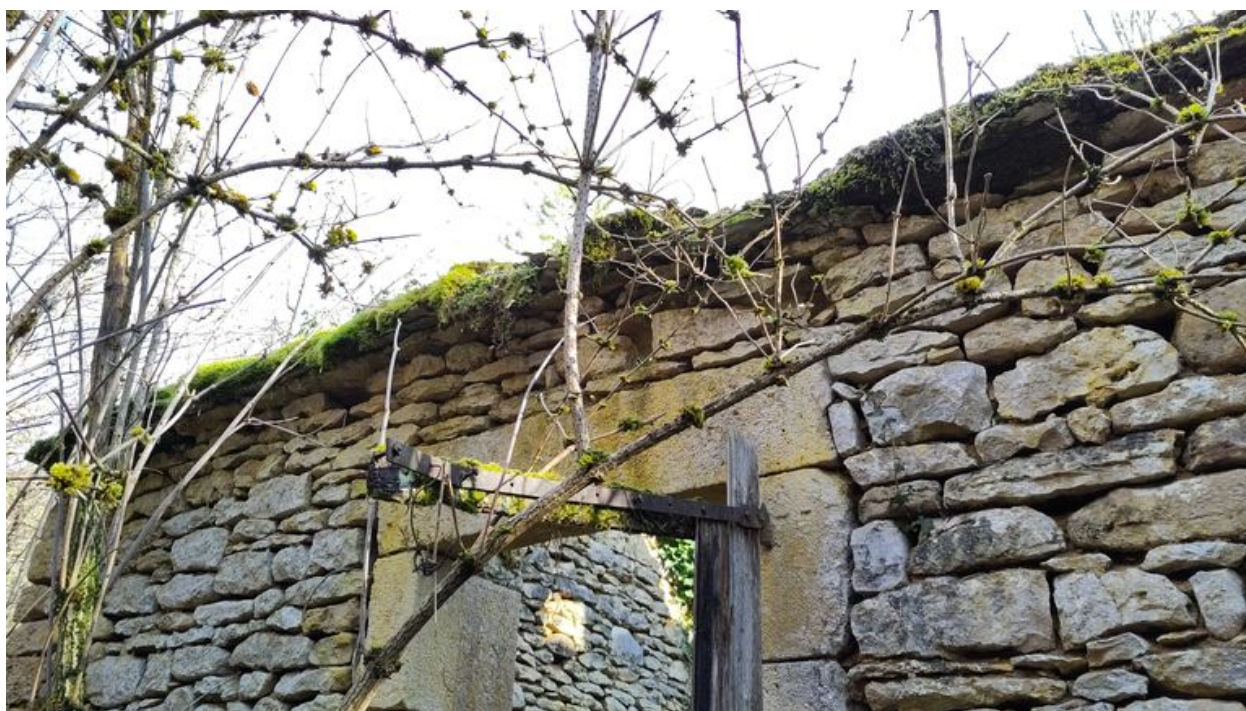
Détail de l'arase du mur gouttereau.
