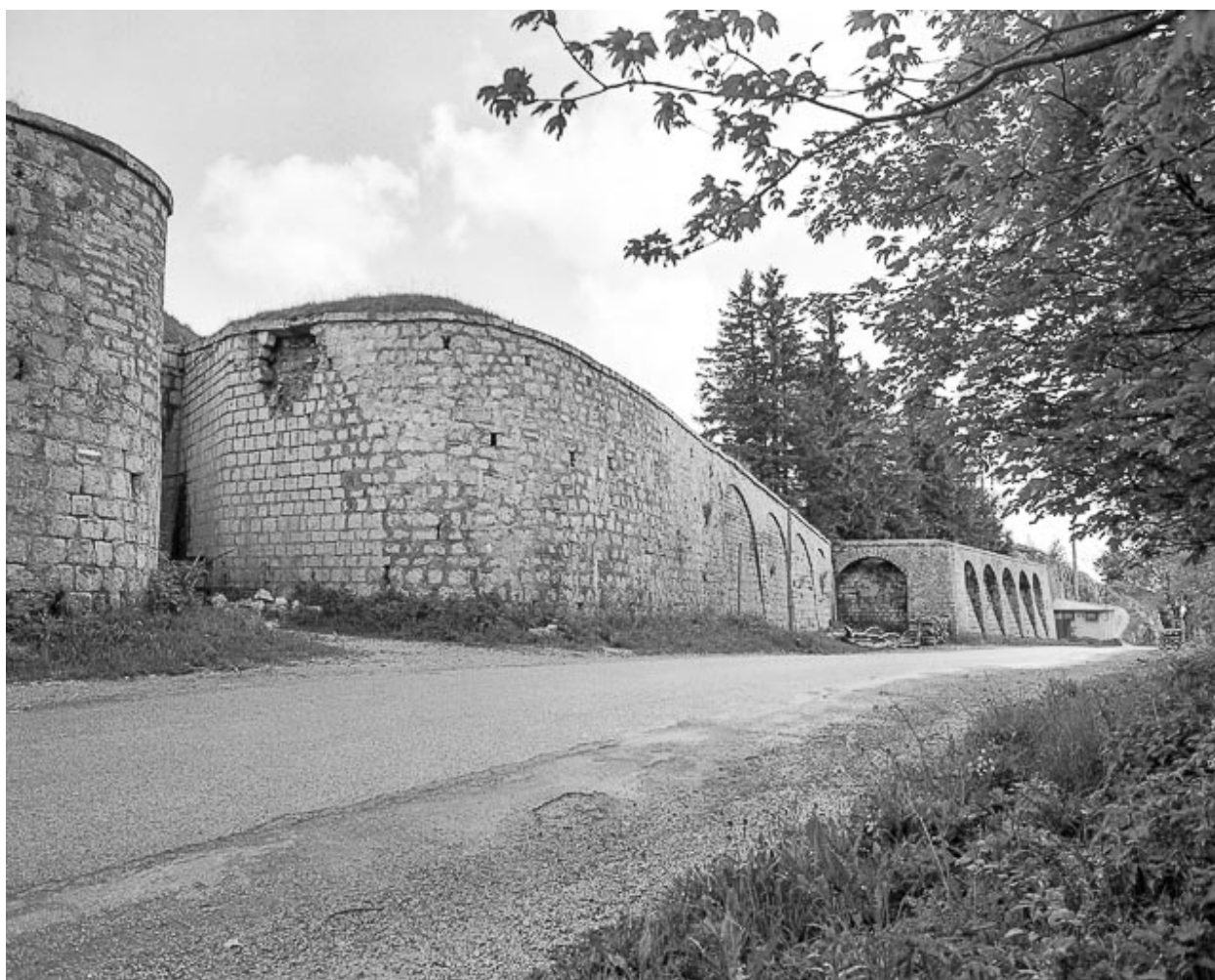
Entrée du fort et créneaux de pied.
