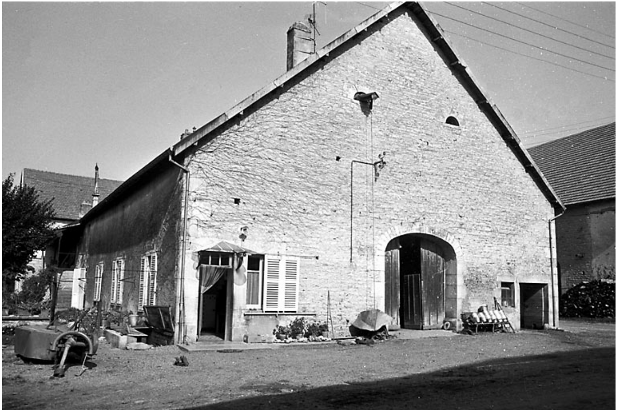
Ferme située 5 rue de Tarcenay.
