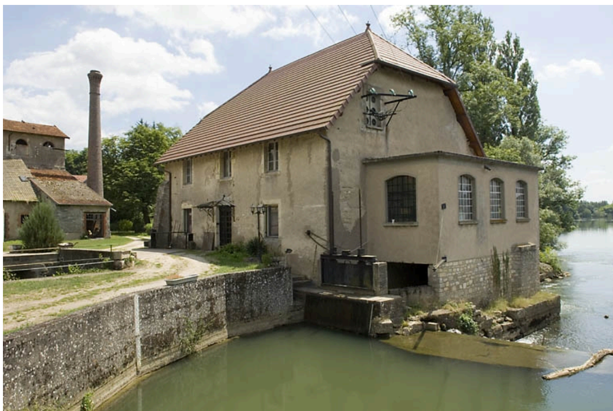
Moulin reconverti en centrale hydroélectrique.
