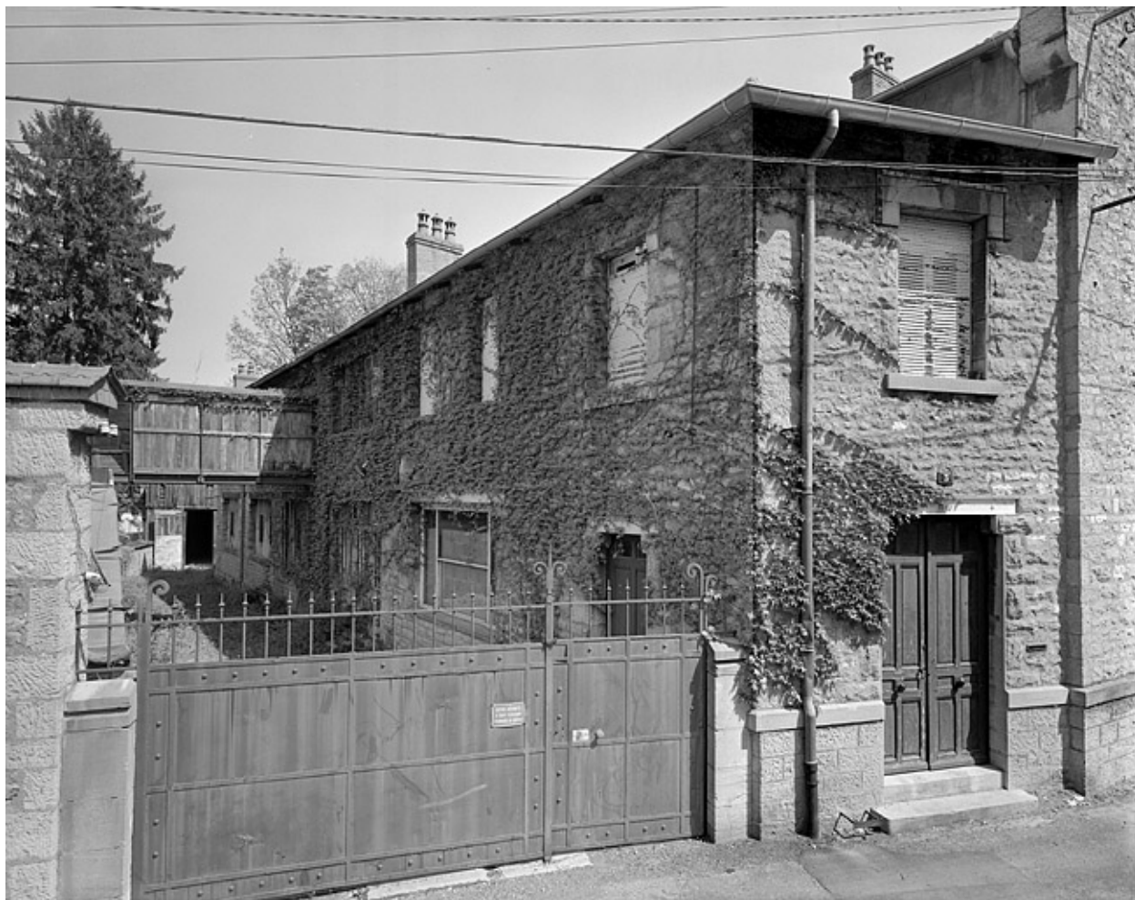
Elévation ouest depuis la rue.
