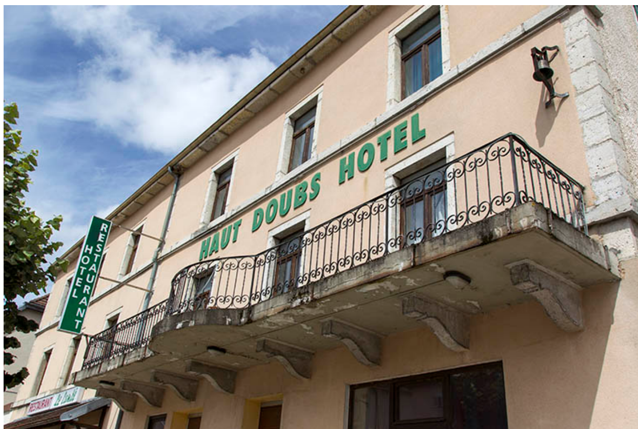
Façade antérieure : balcon.
