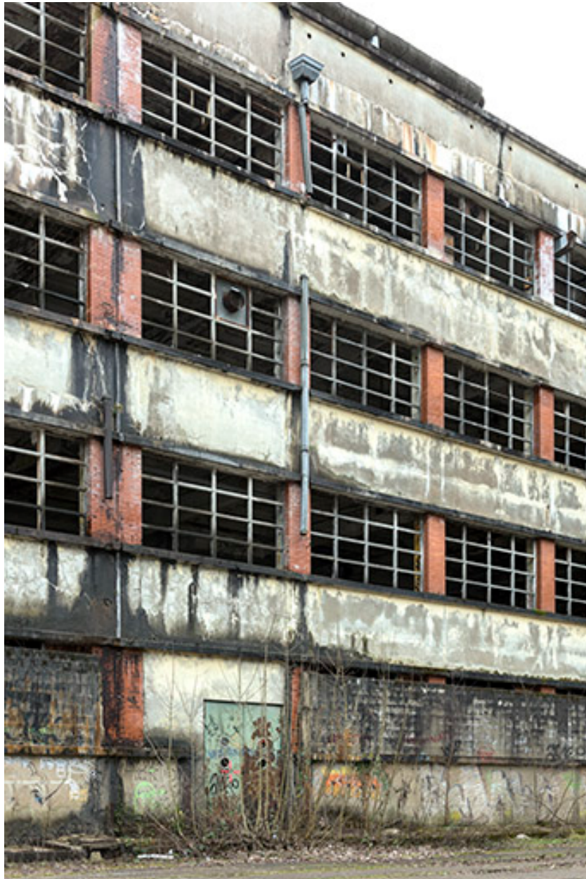
Etat en 2016. Usine A : travées de la façade nord du bâtiment de filature et tissage.
