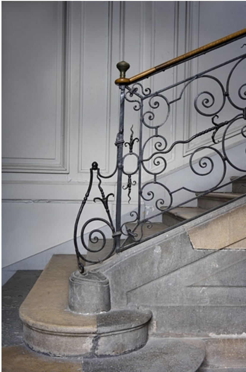
Détail du départ de l'escalier.
