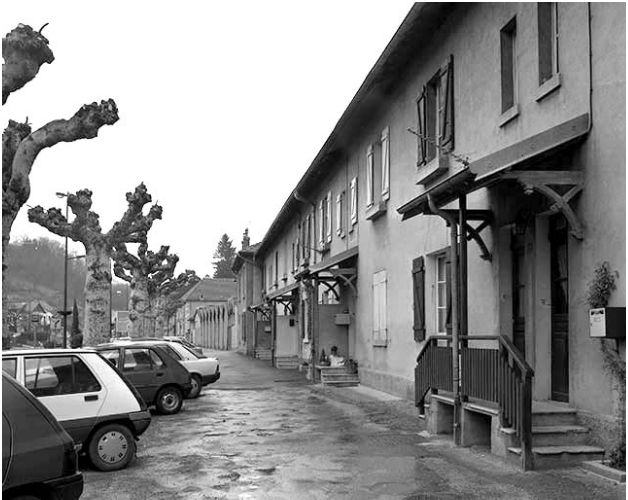
Façade antérieure des logements ouvriers.
