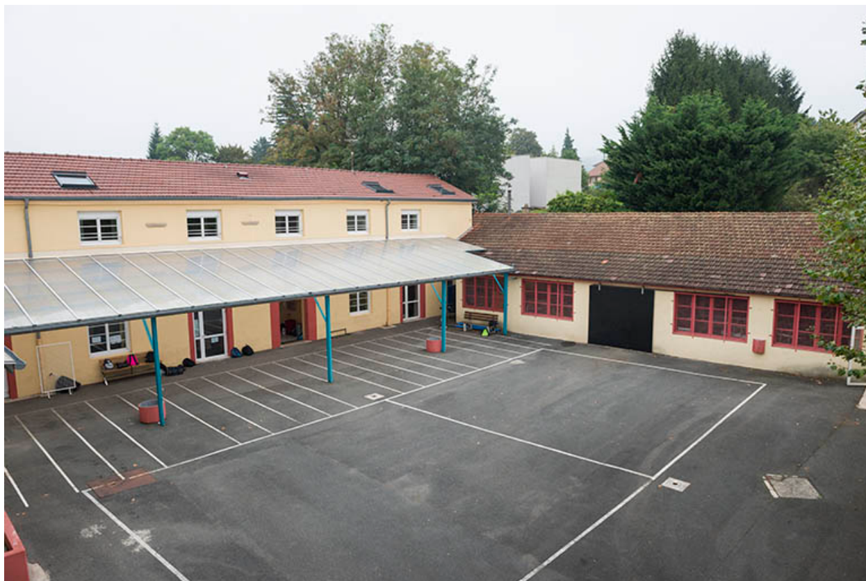
Externat - cafétéria : vue des façades sur cour.
