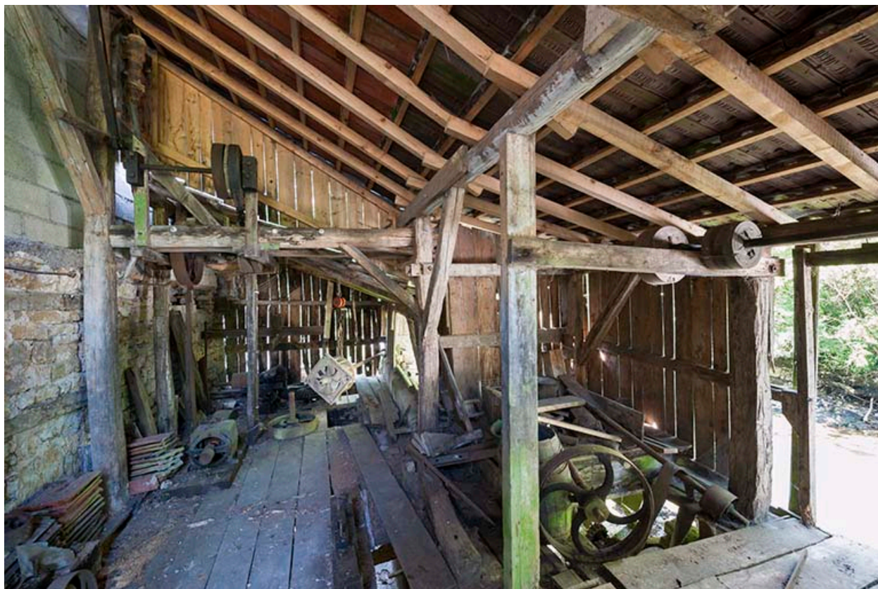
Vue intérieure du bâtiment d'eau.
