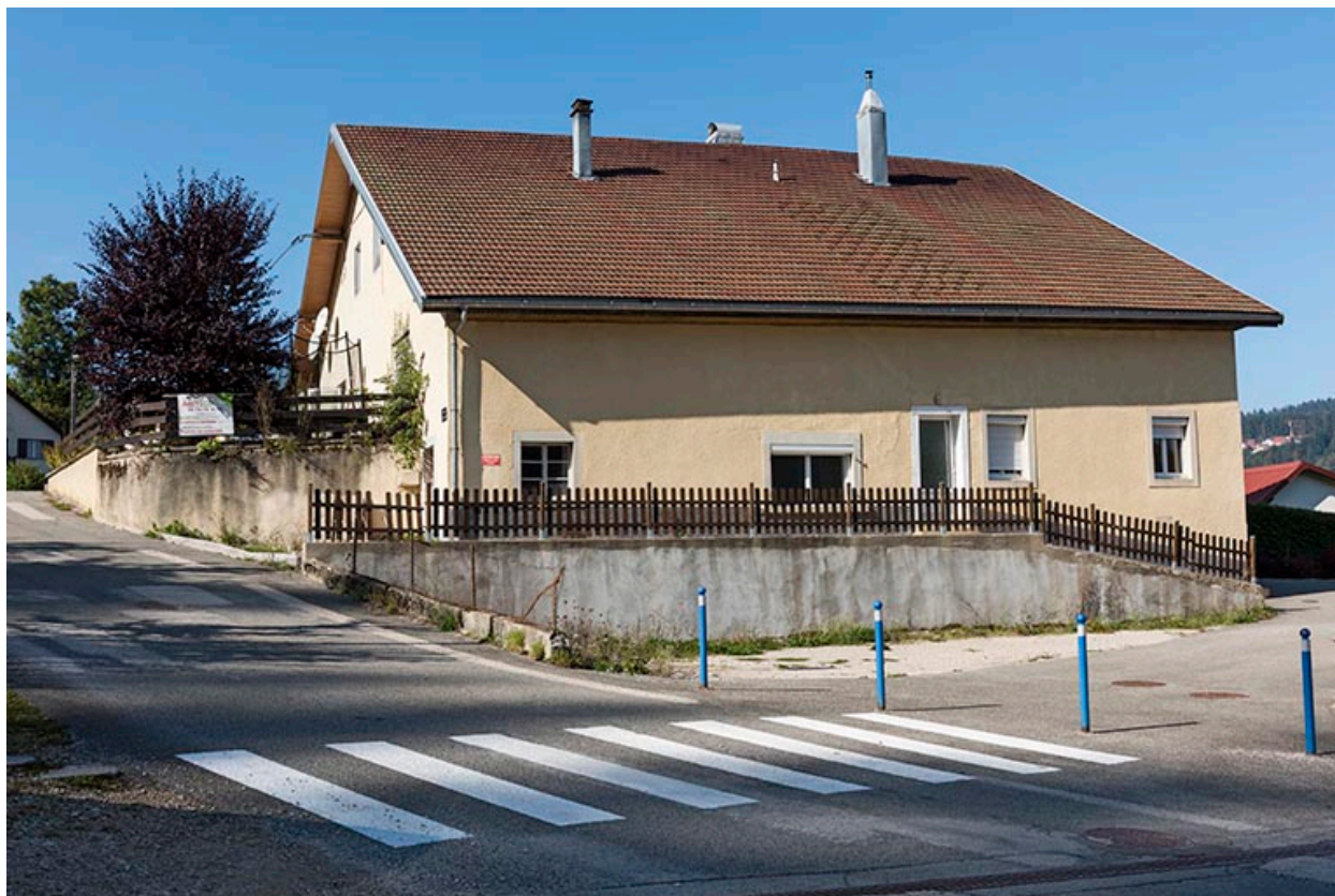
Façade latérale droite, de trois quarts gauche.
