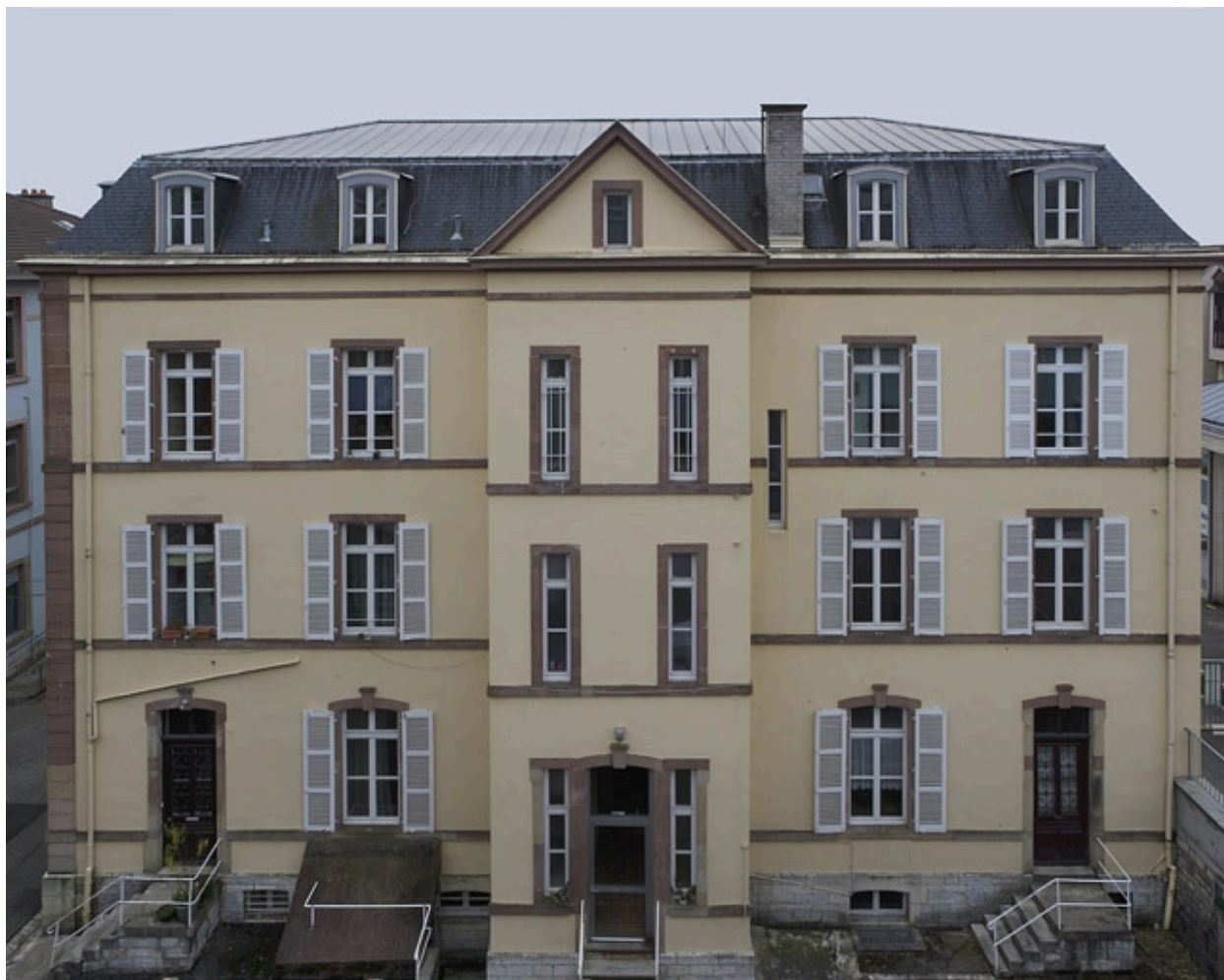
Vue façade postérieure bâtiment A.
