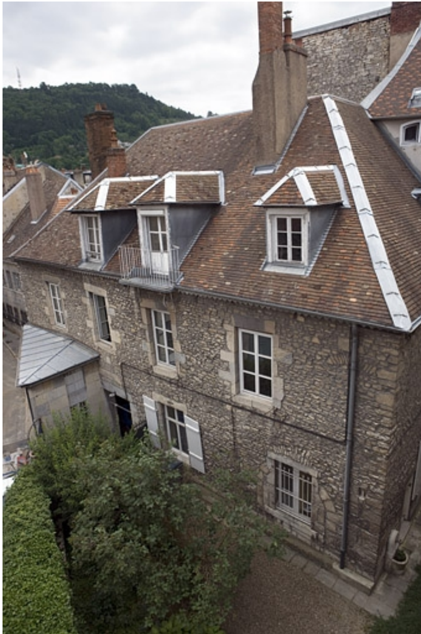
Vue plongeante sur la partie gauche de l'édifice.
