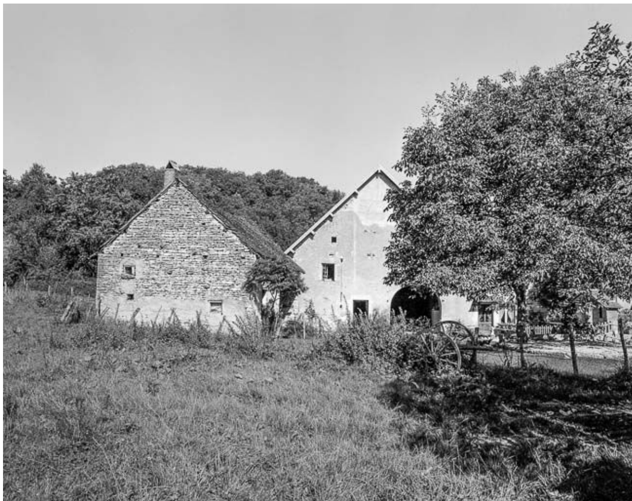
Façade sur cour et dépendances.
