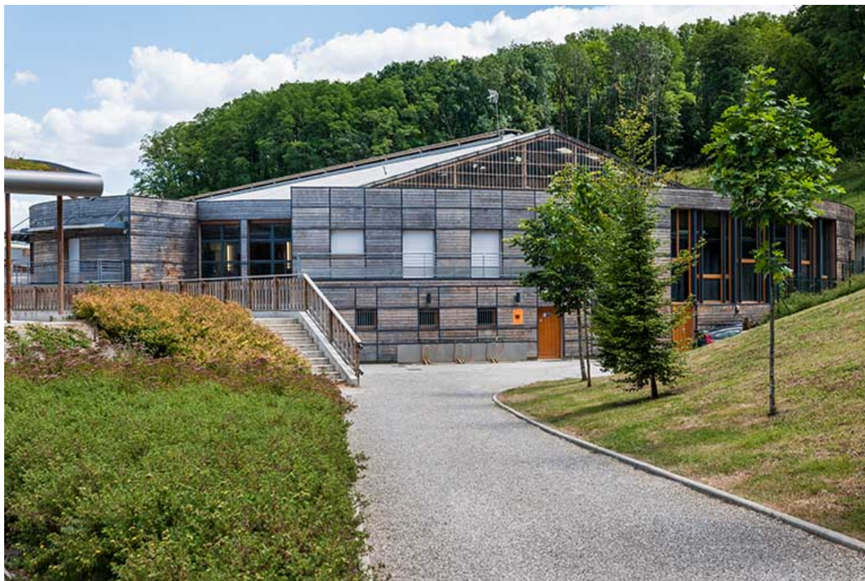
Centre équestre : manège, accès et bâtiment d'accueil.
