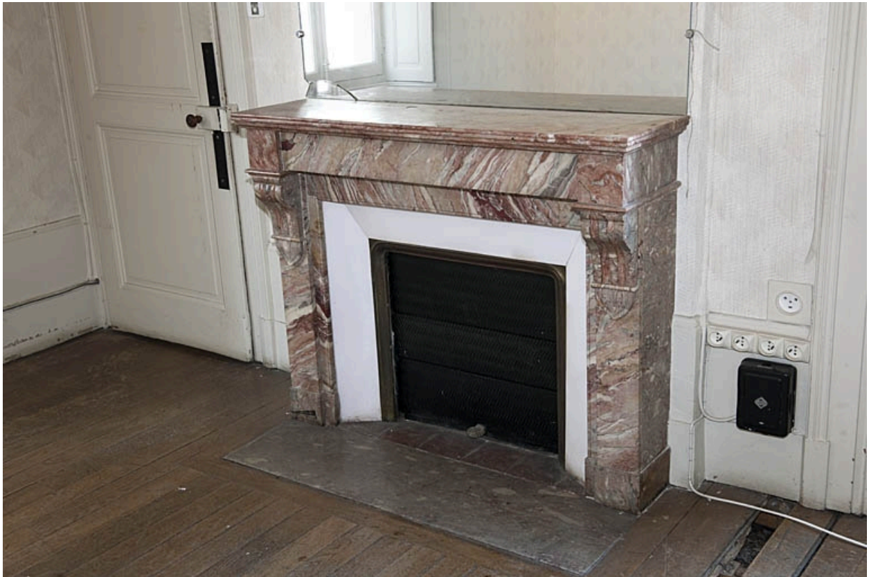
Logis au fond de la deuxième cour : détail d'une cheminée.
