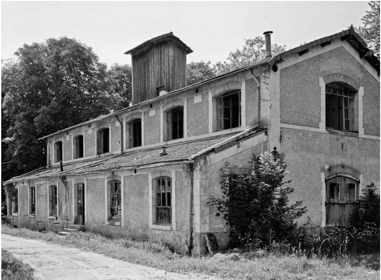
État en 1984, vue depuis le sud-est.
