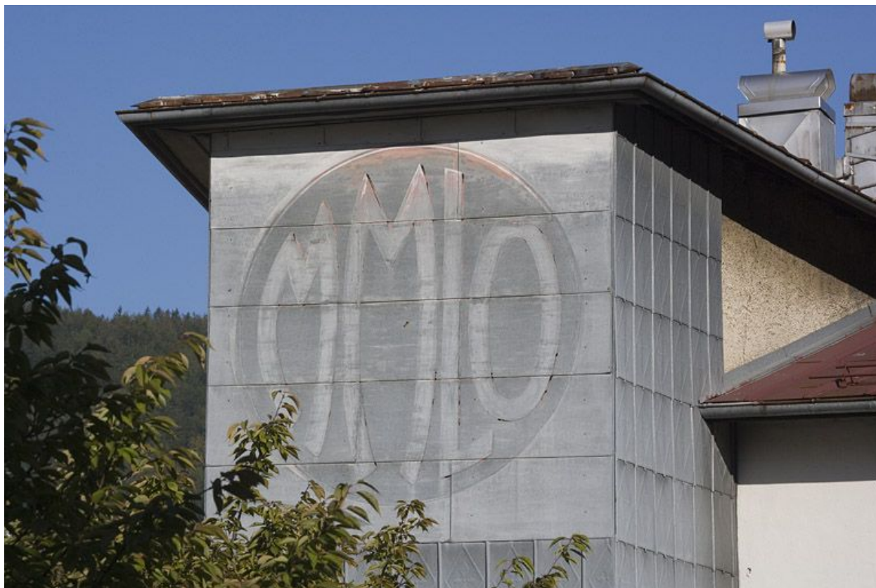
Enseigne sur le bâtiment au 197 rue de la République.
