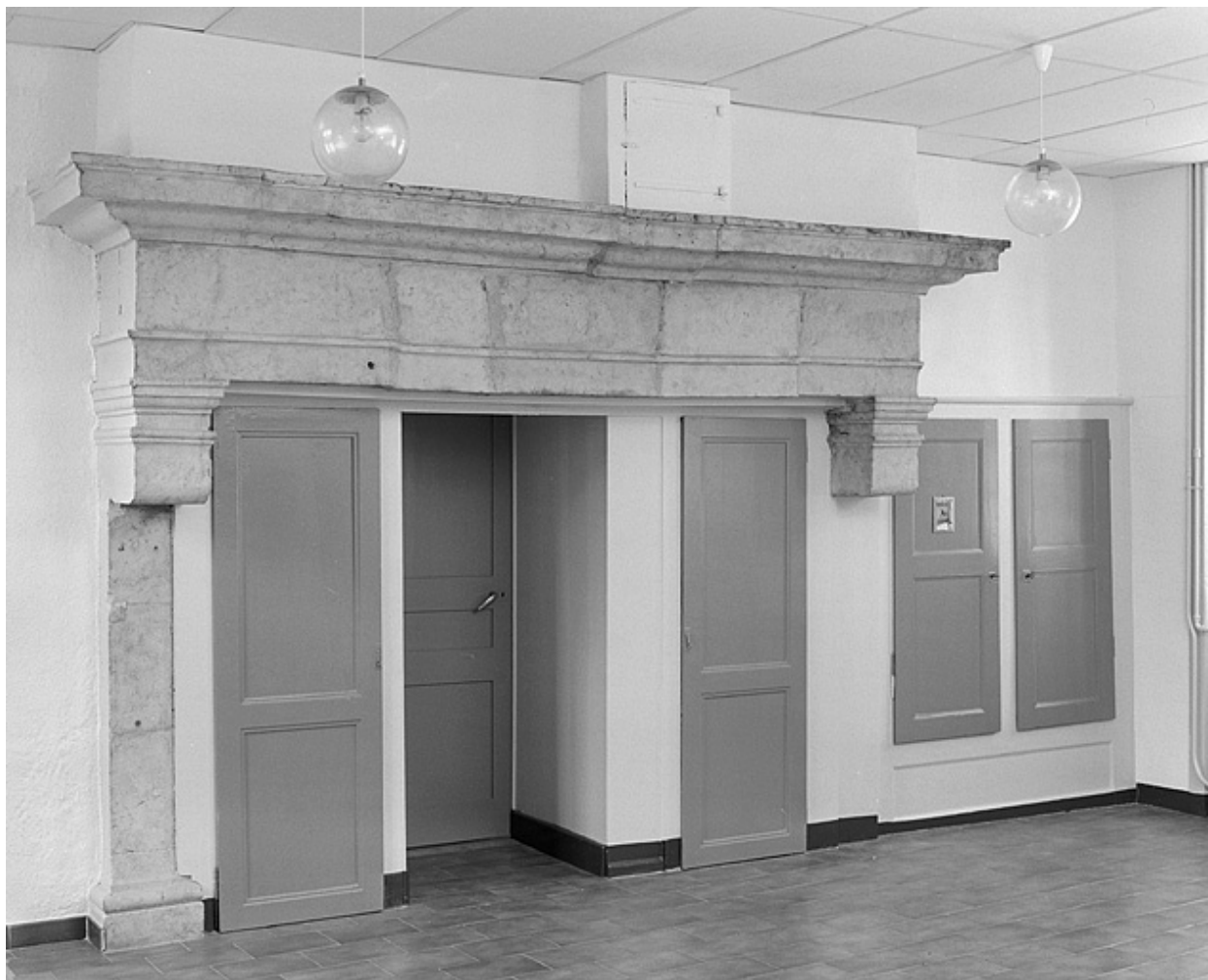
Cheminée dans l'ancienne cuisine au rez-de-chaussée.
