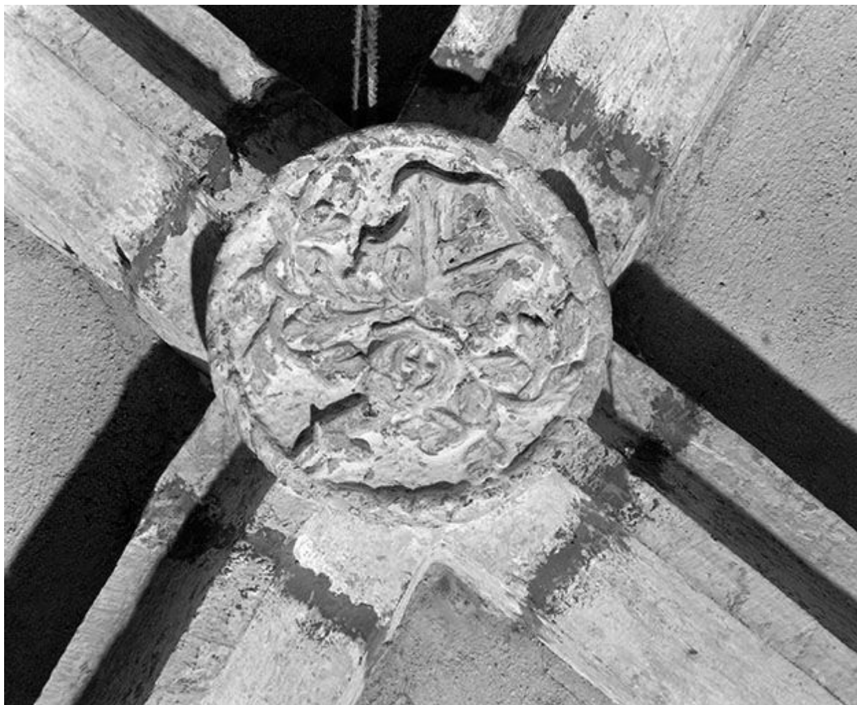
Clef de voûte du chœur.
