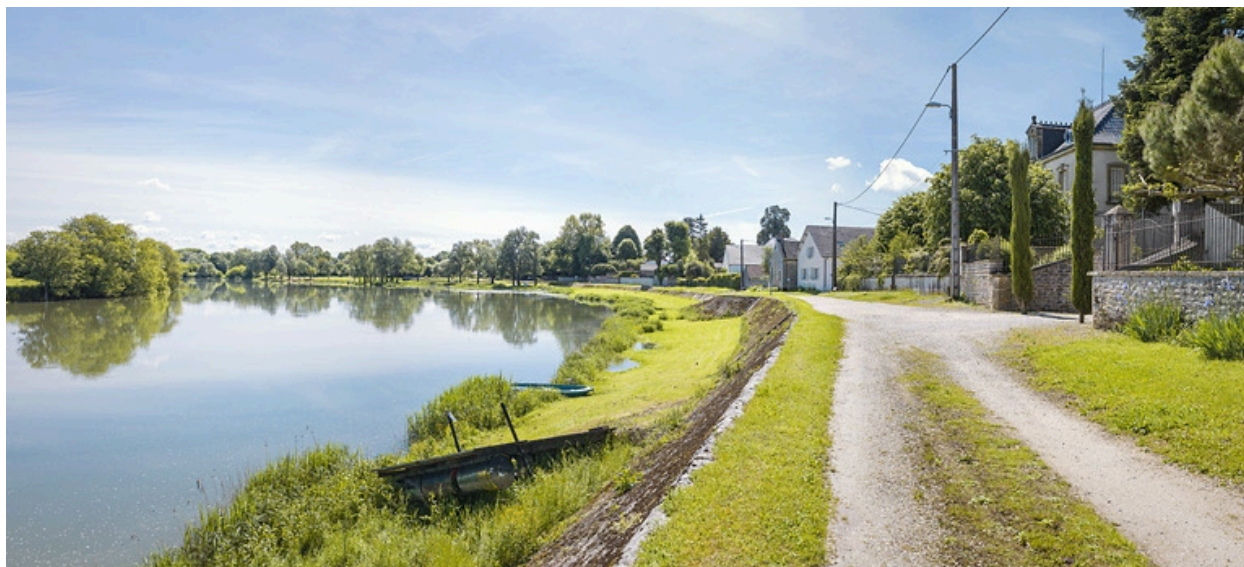
Vue d'ensemble de la digue, prise d'aval.
