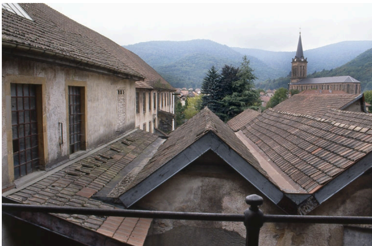
Toitures depuis l'est.
