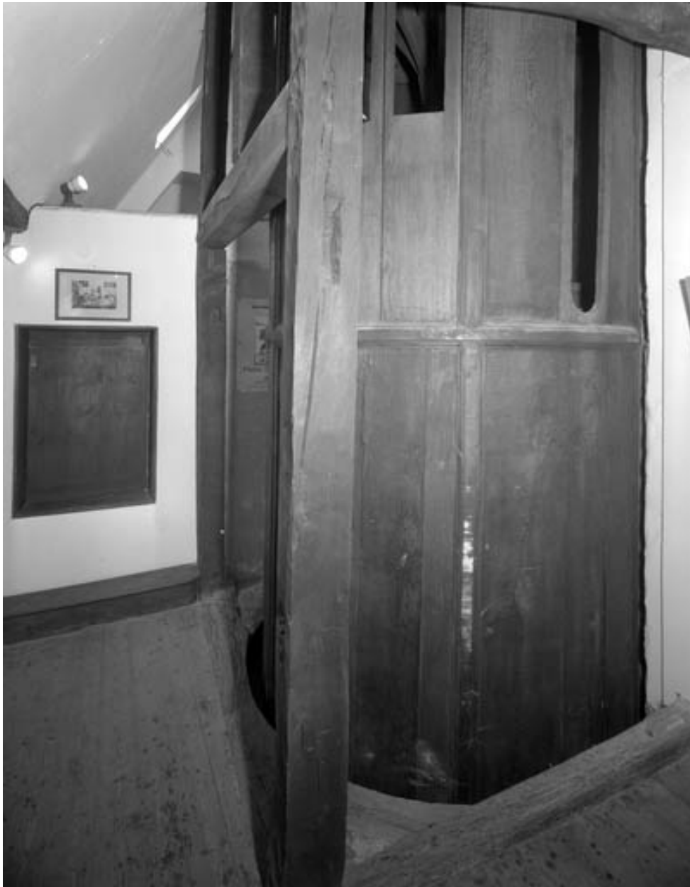
Détail du cylindre pivotant fermé, au niveau de la cellule de saint Pierre Fourier.
