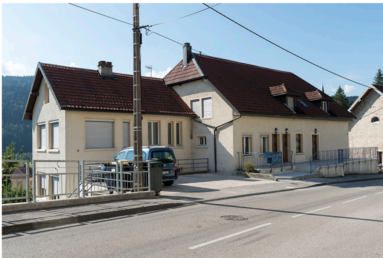
Façades antérieure et latérale gauche.
