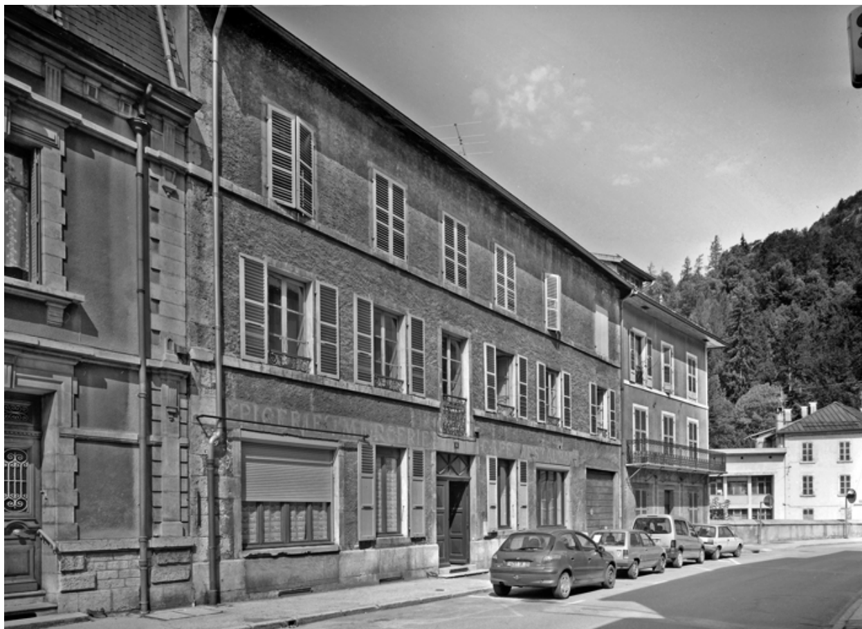
Elévation antérieure, de trois quarts gauche.
