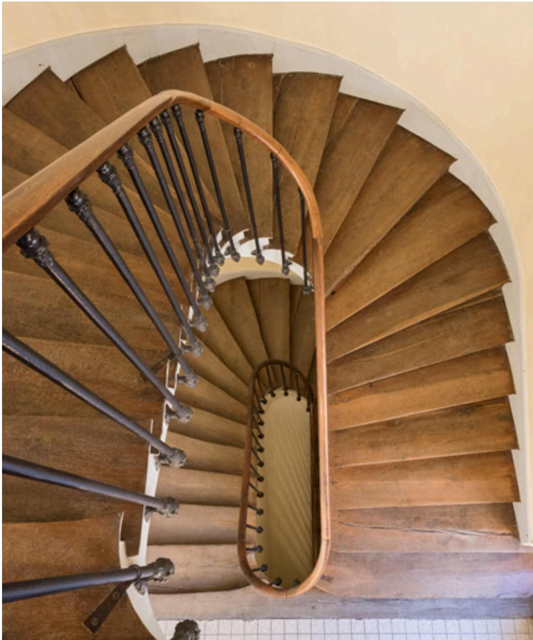
Escalier, vu du palier du comble à surcroît.
