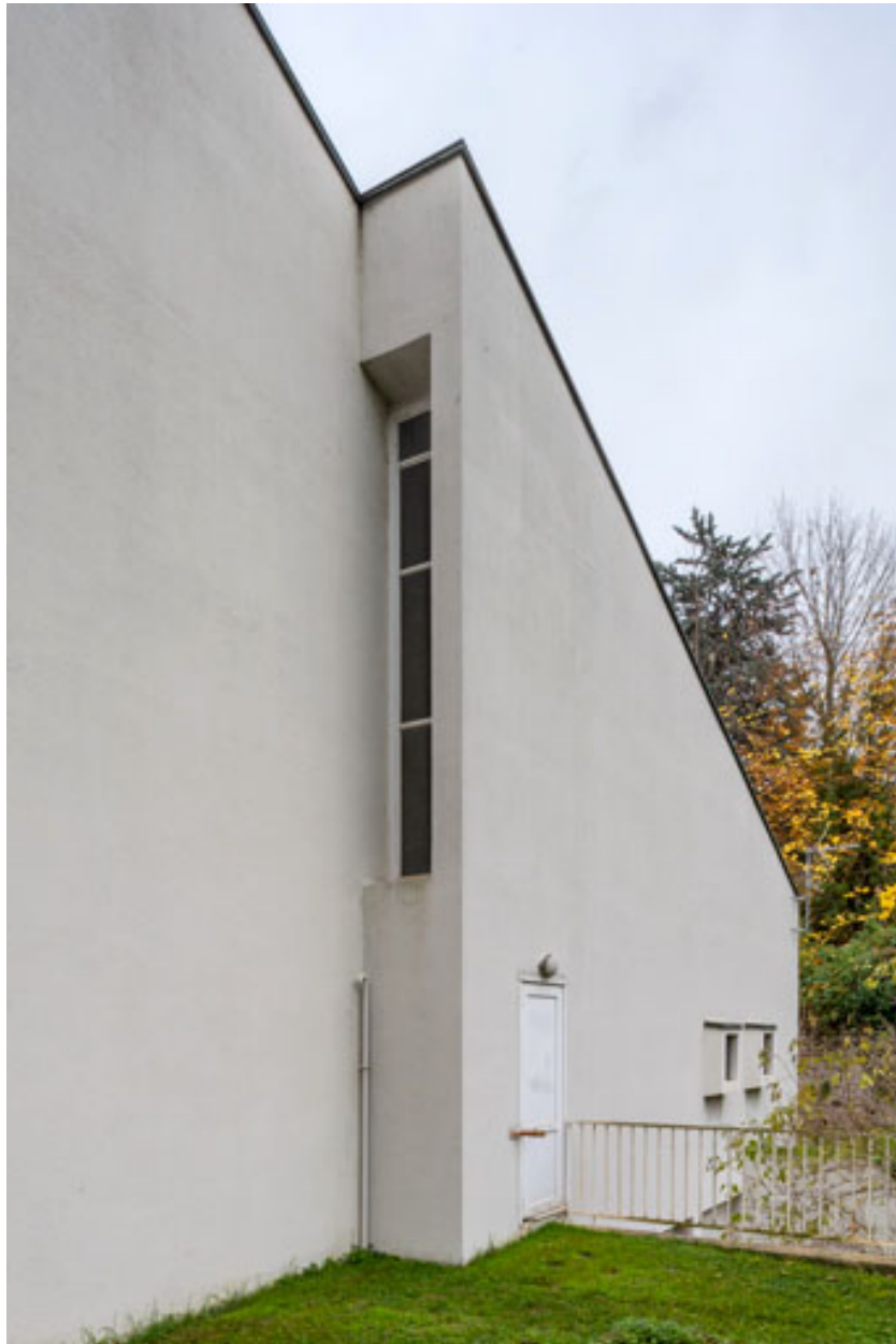
Vue du mur ouest (de trois-quarts, en direction du sud).
