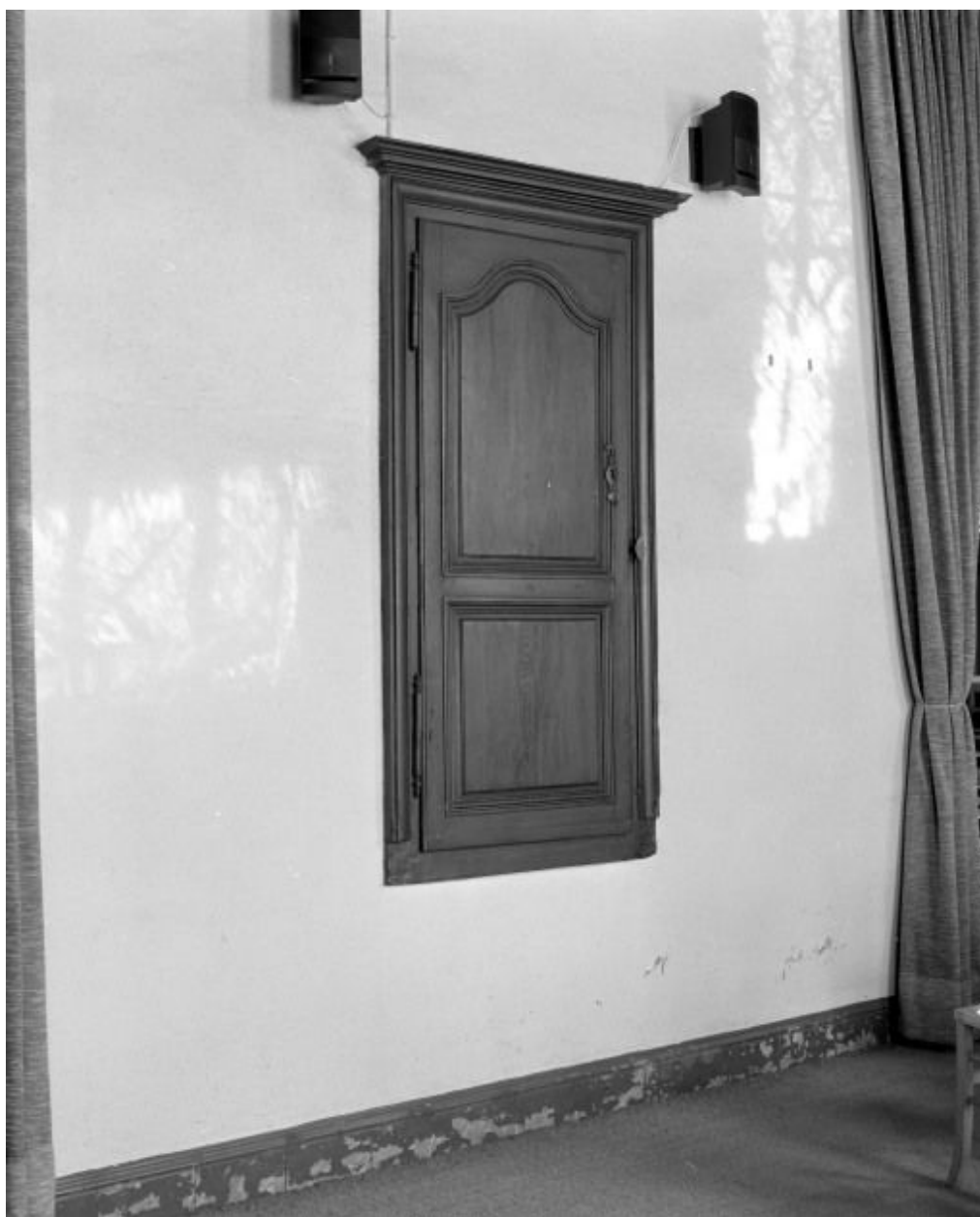
Porte d'accès de la chaire côté chapelle.
