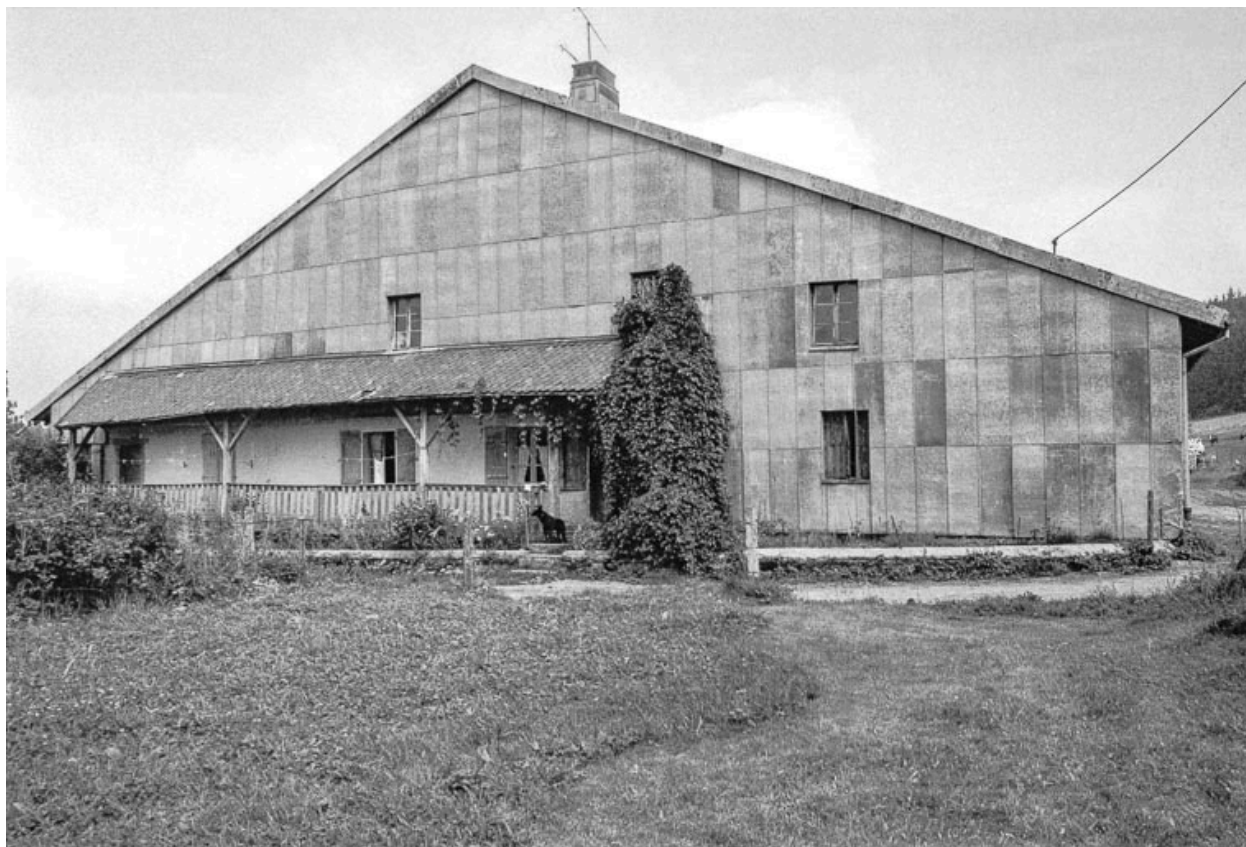
Façade antérieure vue de face.
