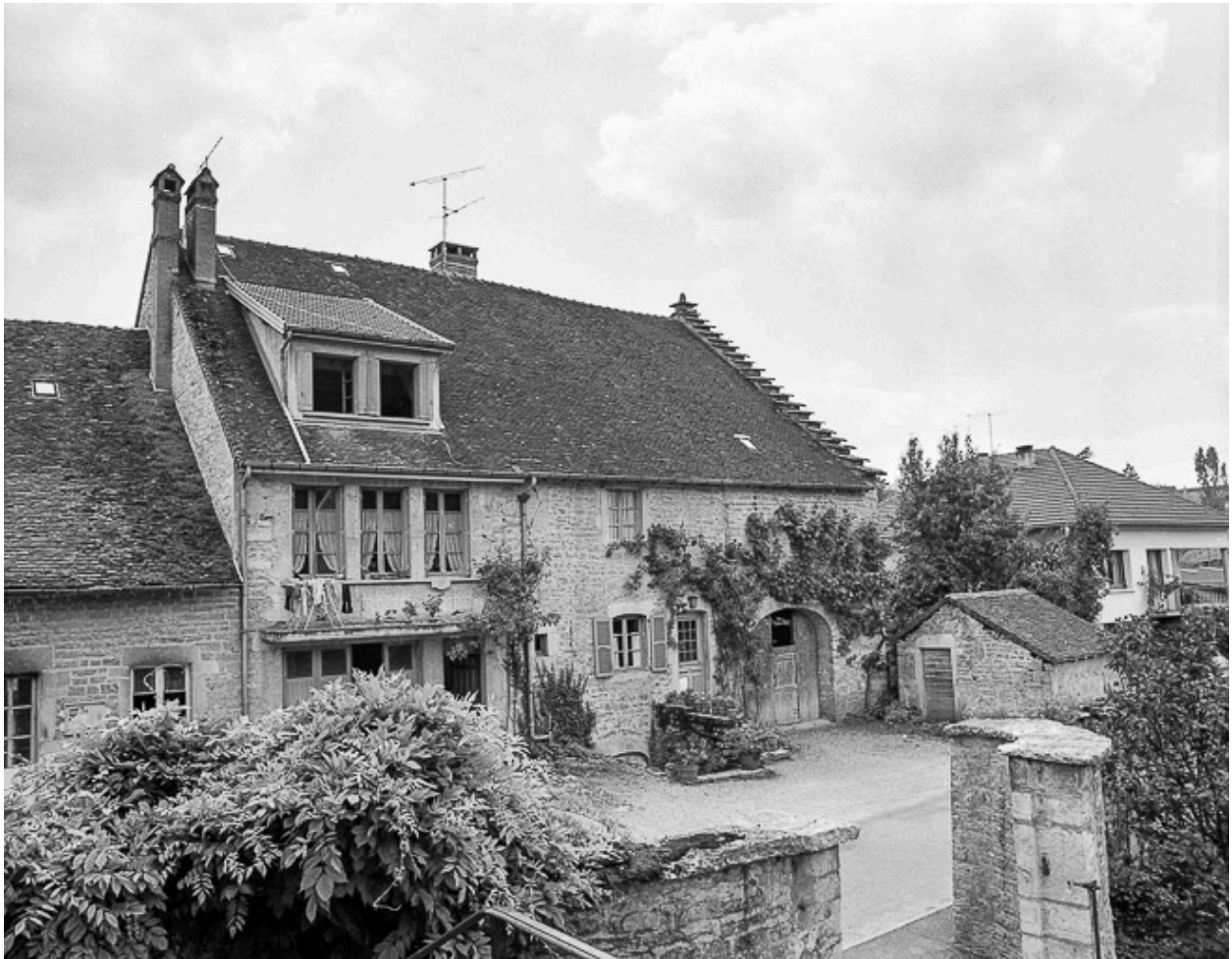
Ferme située rue du Presbytère : vue d'ensemble.
