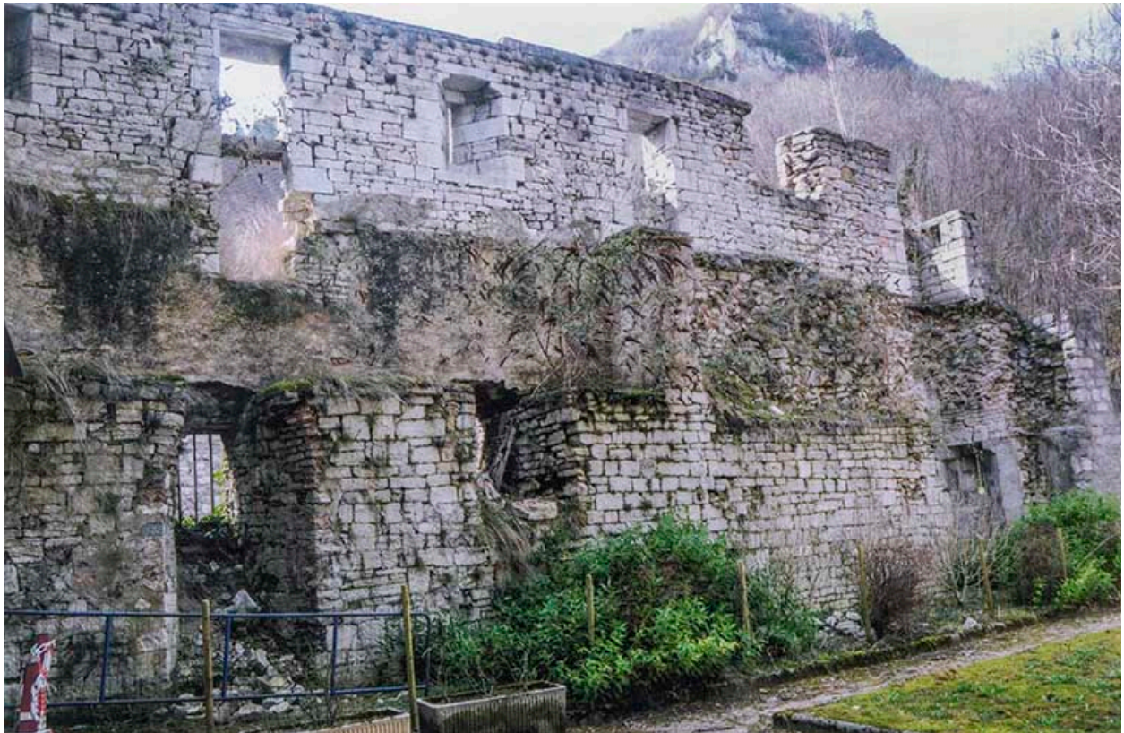
Face interne du rempart conservé au nord du pont Saint-Nicolas, 2011.
