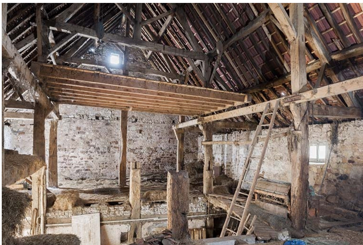
Intérieur de la grange.
