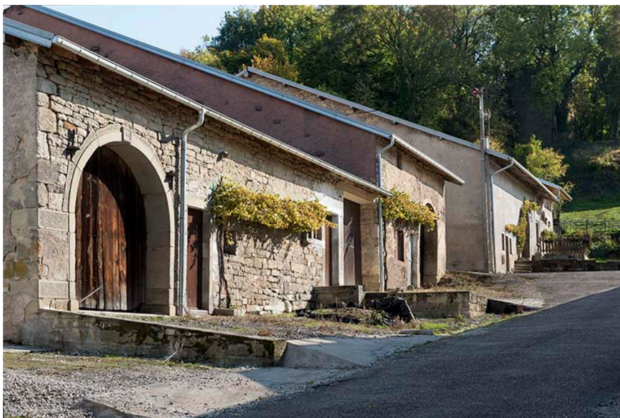
Alignement rue de la fontaine.
