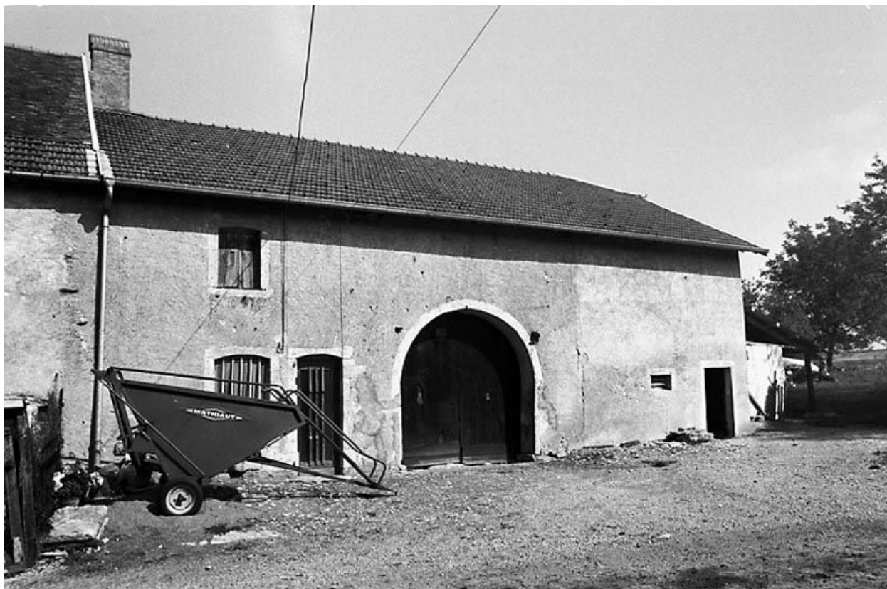
Partie droite de la façade antérieure.
