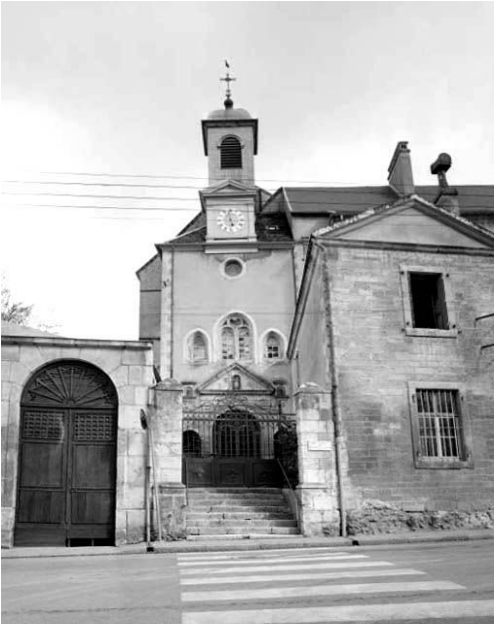
Façade antérieure de la chapelle.
