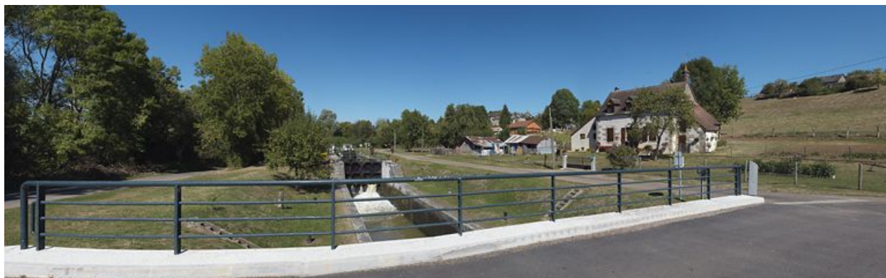
Vue d'ensemble du site d'écluse double.
