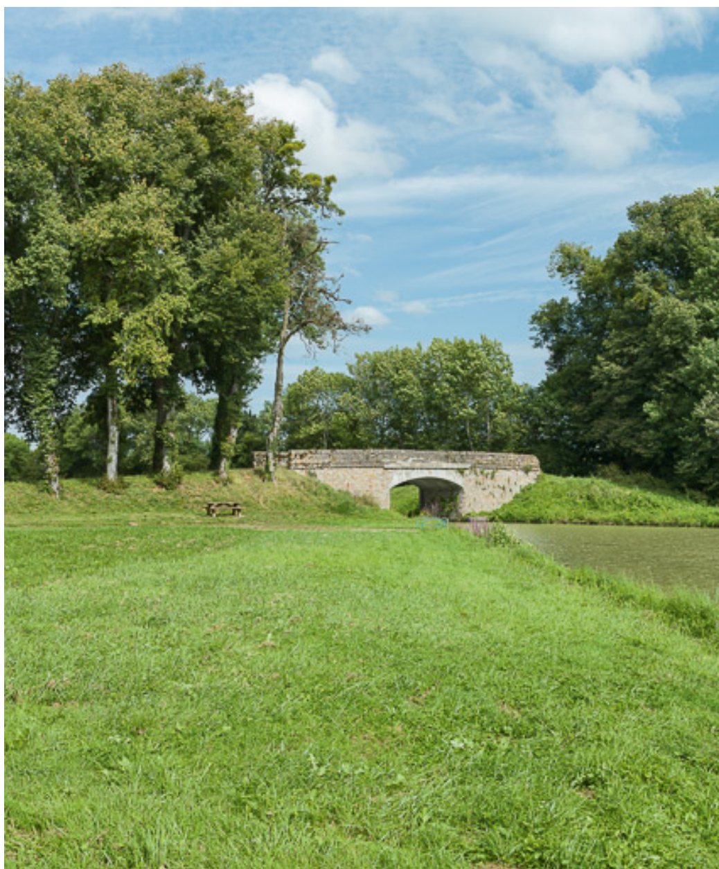
Vue d'ensemble du pont et du site.
