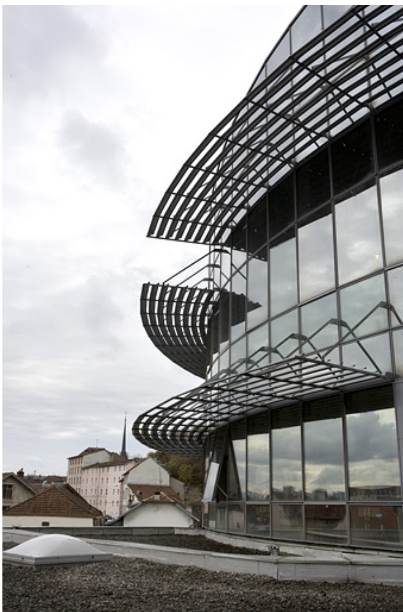
Tour bâtiment D. Détail brise-soleil métalliques.
