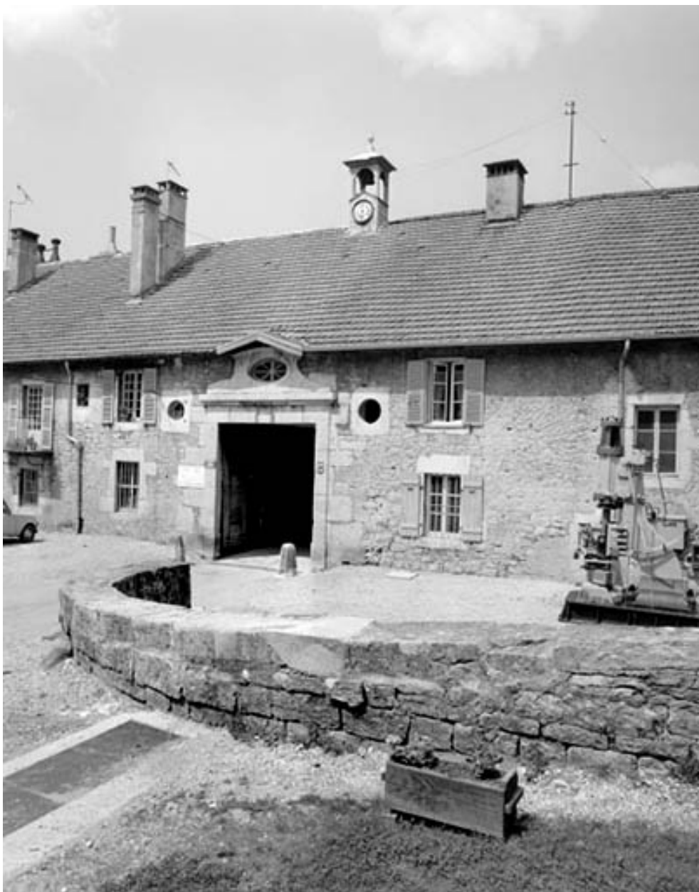
Rampe d'accès et porche d'entrée de l'usine.
